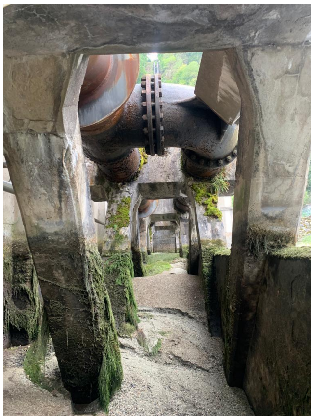
Figura 2.9 Collettore e scarico turbine
